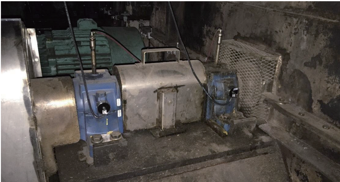
图3：Hengstler OnSite™状态监控系统，及其安装在内置和外置带座轴承套的传感器
